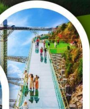
สะพานแก้วมิงกอส
