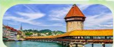
สะพานไมซ์าเปิล
